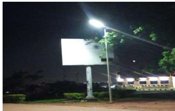
Renforcement de l'éclairage des aires du campus d'Abomey-Calavi (Rectorat, ED-SJPA, ENS, FADESP)
