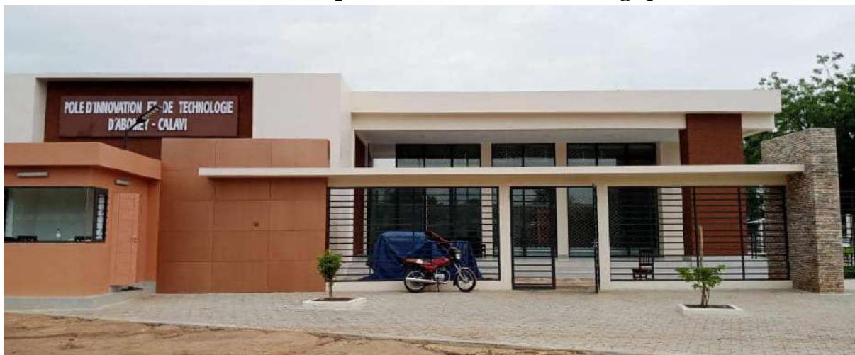
Construction d'un pôle d'innovation technologique grâce à l'appui du Programme de Nations Unies pour le Développement (PNUD)
