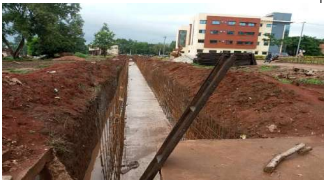
Réalisation de l'aménagement et pavage d'une double voie reliant l'entrée principale du campus de Calavi à l'intersection de UBA en passant par le nouveau rectorat –et la doctrine
